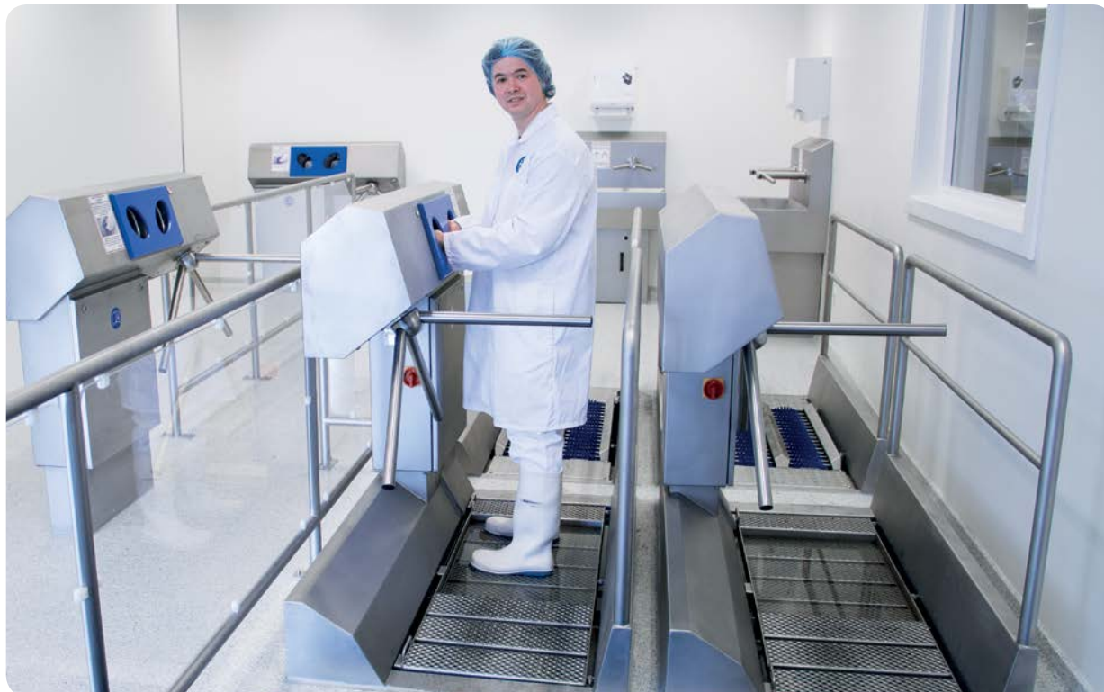
Śluza DZD-HDT-1000-R, zabudowana w posadzce i podłączona do centralnego system dozowania chemii.
