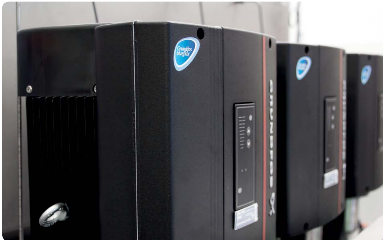
De LDC-Q 720/20 met drie 11 kW pompen.
